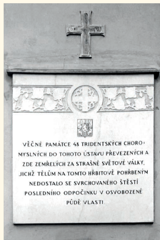
[3] Mramorová deska u vchodu do hřbitovní kaple
