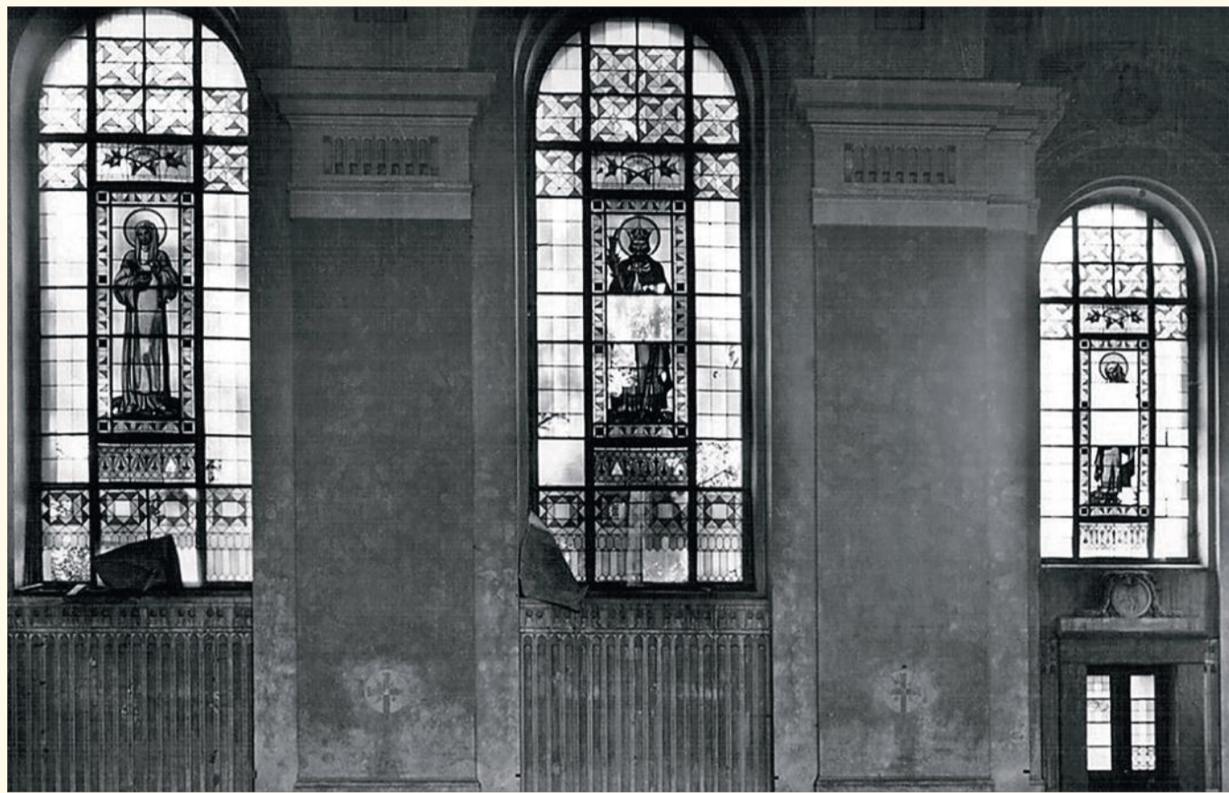
[1] Původní vitráže z 20. let s vyobrazením světců v levé části kostela. Stav 50. léta 20. stol.
